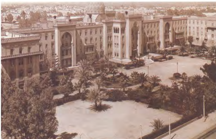
Vue d'ensemble du Palace Hotel au temps de sa construction.
